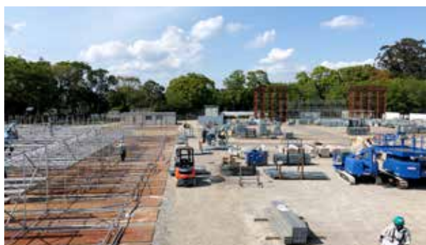
2021年4月 競技会場と観客席の躯体を建設中
