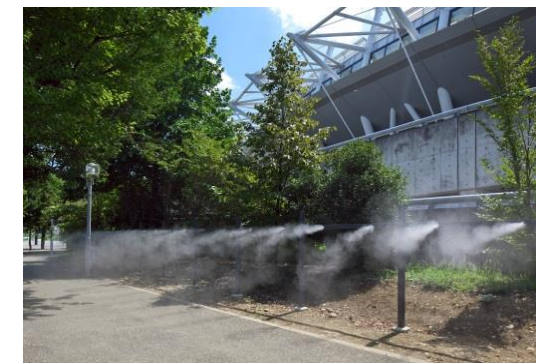
ドライ型ミストによる暑さ対策 （東京スタジアム）
