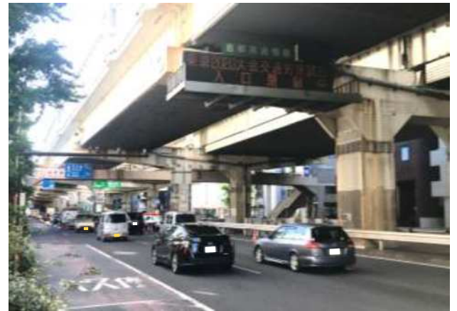
入口閉鎖（国道246号 三軒茶屋入口周辺）
