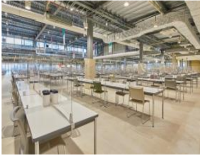
パーテーション等の設置状況①
