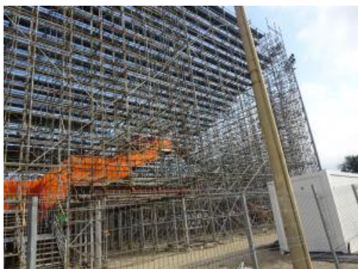
解体されるビーチバレーアリーナ
