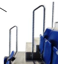
縦通路手すり
