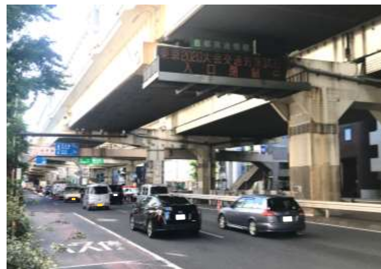
入口閉鎖（国道246号 三軒茶屋入口周辺）
