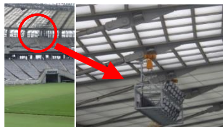
競技用照明（仮設）の設置状況
