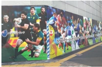
スバルビル解体工事仮囲い （新宿駅西口）
