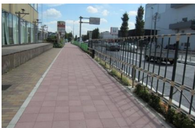
歩道に設置したパイプ柵 (甲州街道)
