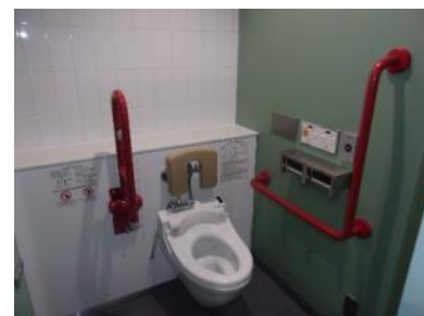
トイレの洋式化完了後の状況
