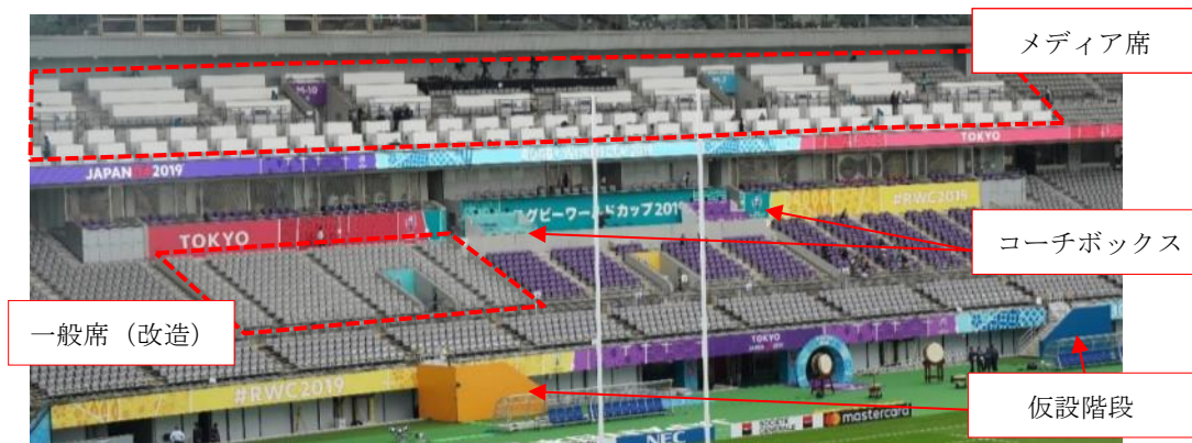
スタンド改造後の状況
