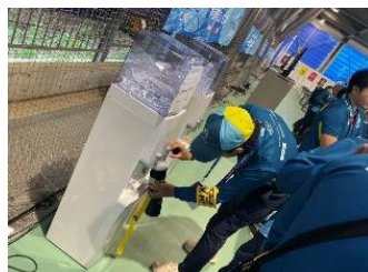
ウォーターサーバーの設置
