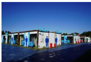
仮設トイレ設置状況
