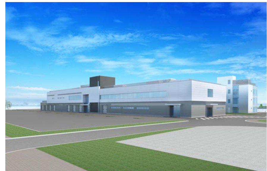
艇庫棟(西側から)
