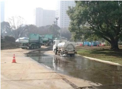
写真 8.6.1-13 散水車による鉄板上の散水
