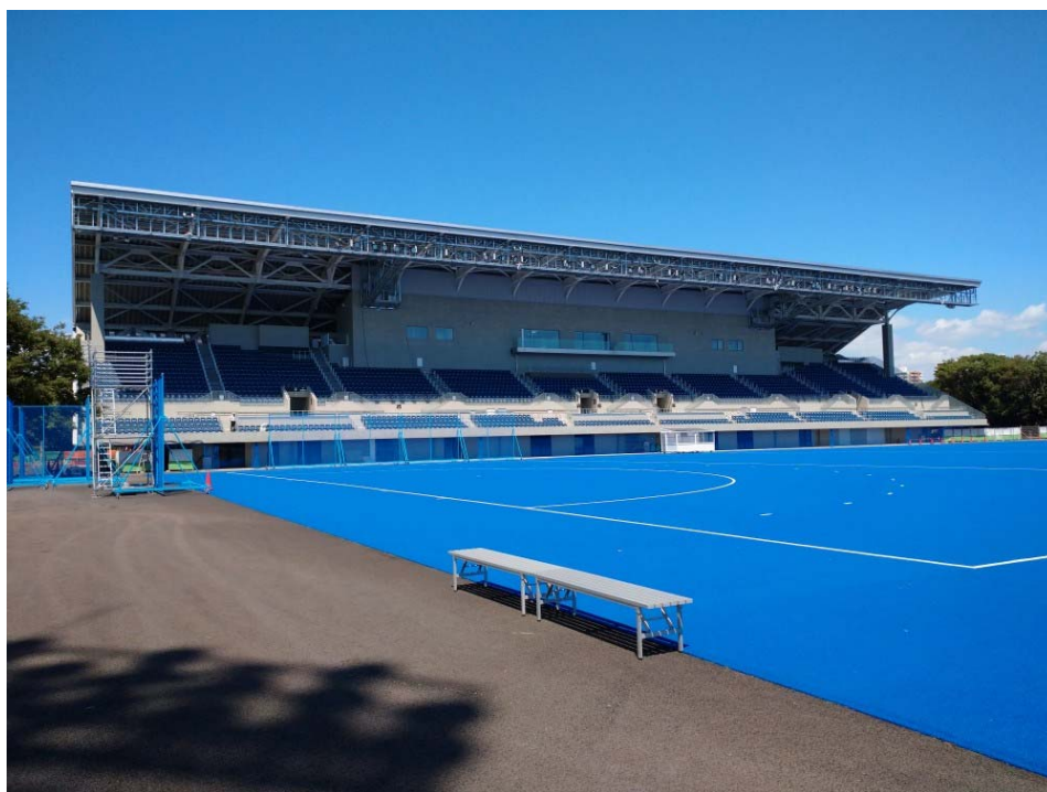
写真 4. 2-2(1) メインピッチの状況図（令和元年 7 月）
