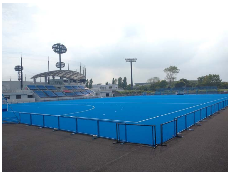
写真 4. 2-2(2) サブピッチの状況図（令和元年 7 月）
