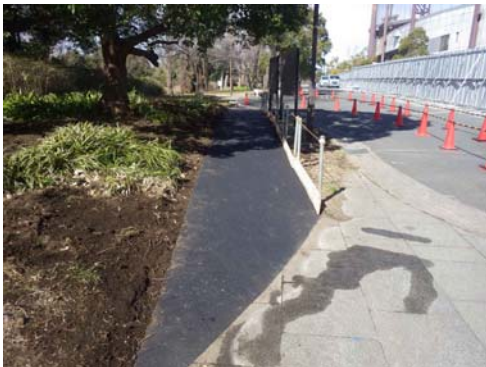
写真 8.8-3 迂回路、道路保安用品設置
