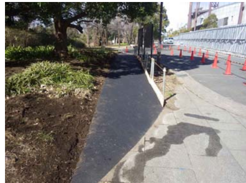
写真 8.9-4 迂回路、道路保安用品設置
