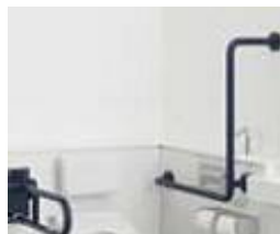
(車いす対応トイレ)
