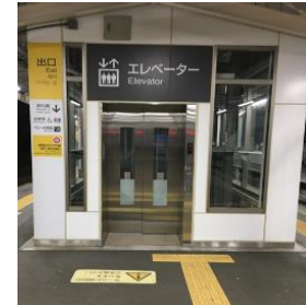
【駅構内のエレベーター】
