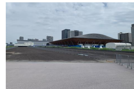
2 入口から2Fコンコースまでの盛土スロープ（仮設）
