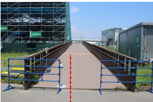
スロープ（仮設）
