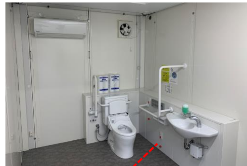
車いす対応トイレ
