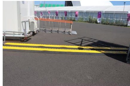
2 ケーブルジャケット（仮設）
