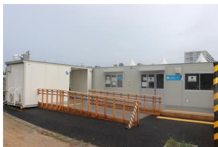
3 多機能トイレ・観客用医務室（仮設）
