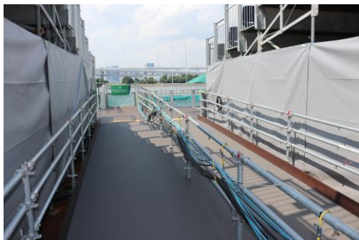
スロープ（仮設）
