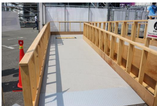
スロープ（仮設）
