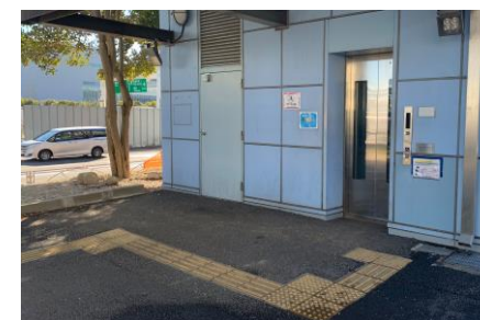
2 エレベーター（恒設）
