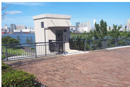
1 エレベーター（恒設）
