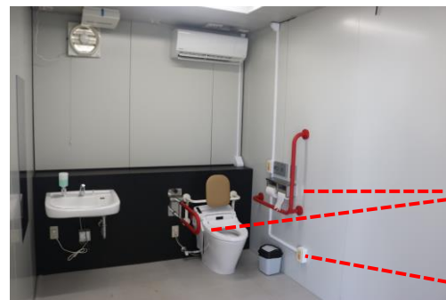
車いす対応トイレ
