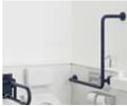
(車いす対応トイレ)
