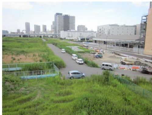
②区画道路（区画整理事業で整備中）
