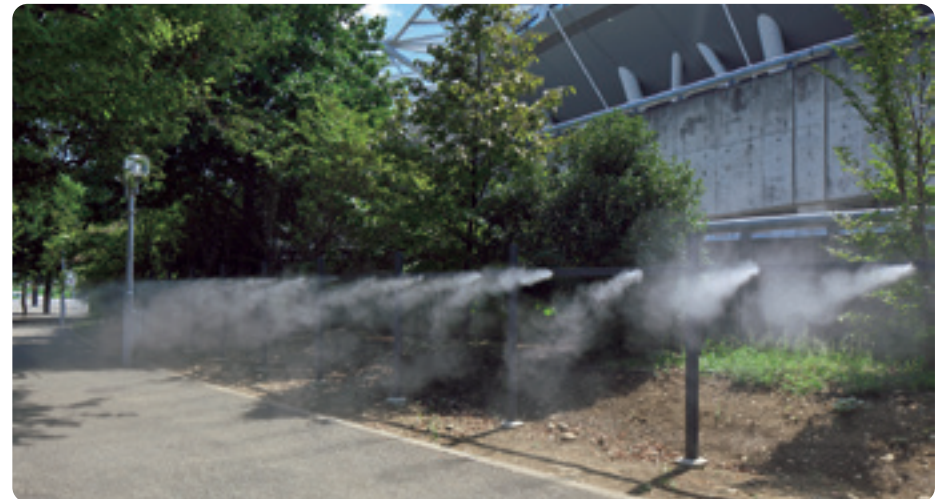
ドライ型ミストによる暑さ対策（東京スタジアム）
