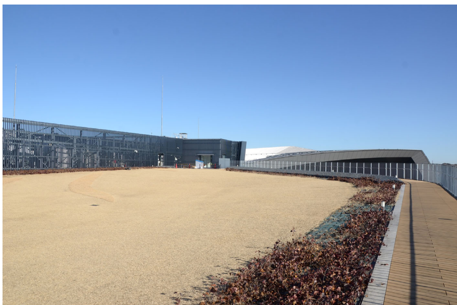
写真 8.7-2 サブアリーナの屋上緑化
