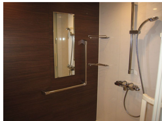
手すりを設けたシャワー
