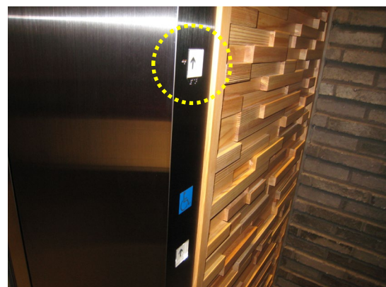
操作ボタンの点字表示
