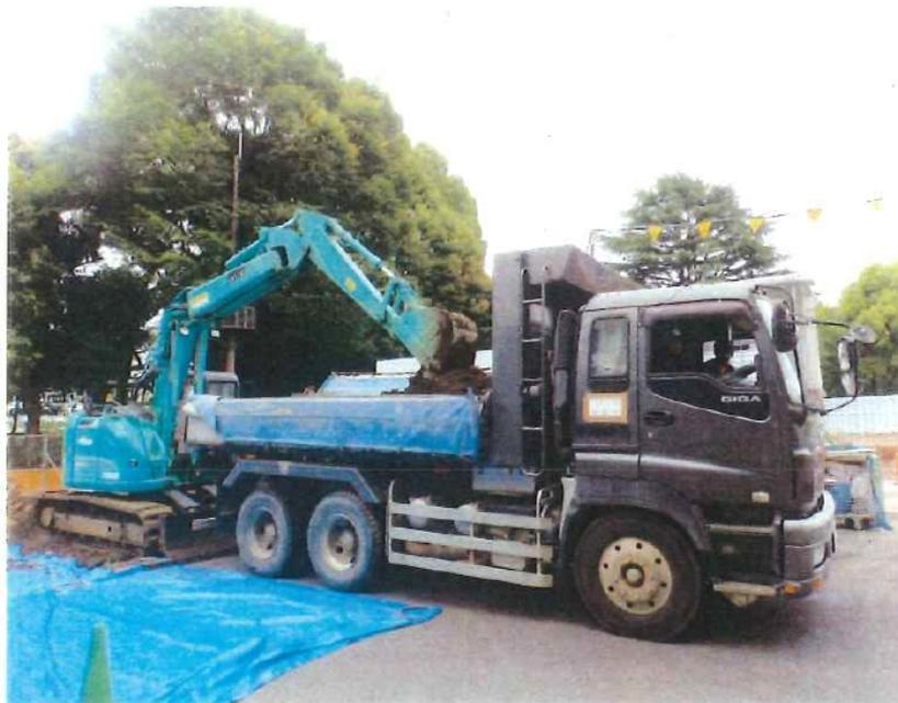
写真8.1-1 汚染土壌の掘削、積み込み状況
