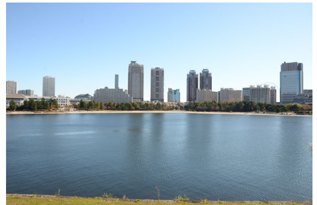
(東京都撮影) 台場公園（第三台場）よりおだいばビーチを望む (お台場海浜公園)
