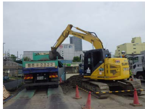
写真 8.1-4 トラックスケールによる計量
