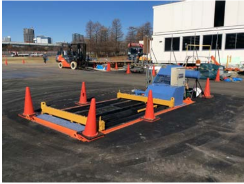
写真 8.1-1 タイヤ洗浄設備
