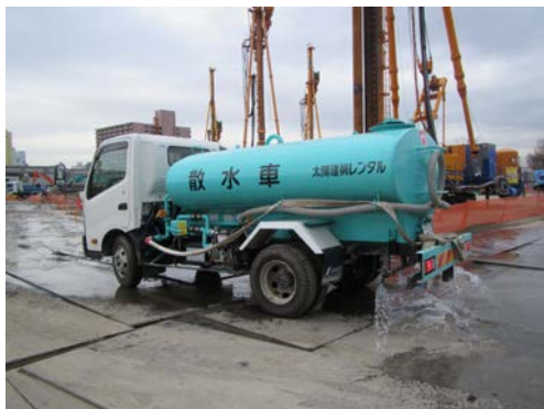
写真 8.1-11 散水車による散水
