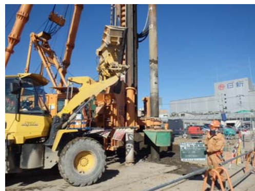
写真 8.2-8 静的締りめ砂杭工法
