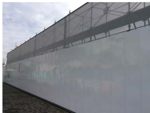
写真 8.2-5 仮囲い及びメッシュシート
