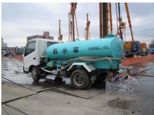
写真 8.3-3 散水車による散水
