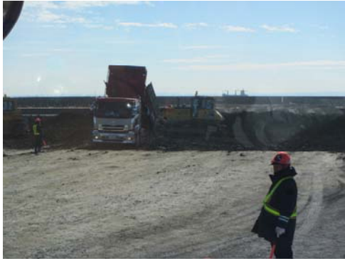
写真 8.4-1 建設発生土の再利用施設への搬入
