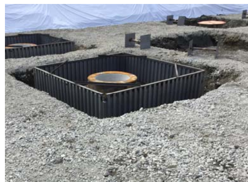
写真 8.4-4 鋼製型枠の使用
