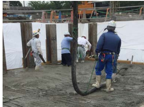
写真 8.4-6 再生骨材コンクリート打設
