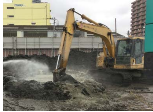
写真 8.4-2 杭泥土改良状況
