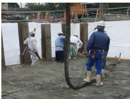
写真 8.5-1 再生骨材コンクリート打設
