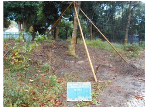
写真 6.8.2-6 既存樹木の根回し
