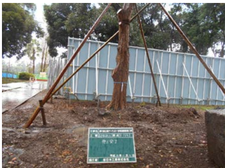
写真 6.8.2-5 既存樹木の根回し
