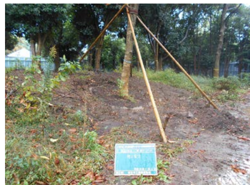
写真 6.8.3-6 既存樹木の根回し
