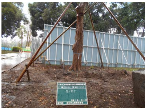
写真 6.8.3-5 既存樹木の根回し
