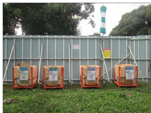
写真 6.8.5-7 分別回収の状況
