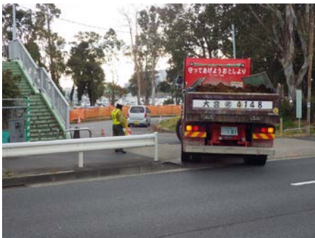
写真 6.8.6-1 建設発生土搬入
