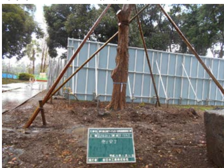
写真 6.8.2-5 既存樹木の根回し
