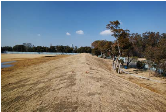
写真 5.1-1(3) 築山（矢止め）の整備状況
