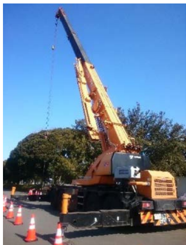
写真 6.8.4-11 建設機械稼働時の安全対策
