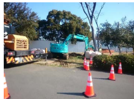
写真 6.8.4-10 建設機械稼働時の安全対策
