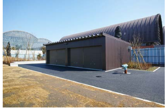
写真 5.1-1(2) 建築物（倉庫）の整備状況
