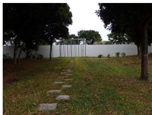
写真 6.8.4-2 計画地周辺に仮囲いを設置
