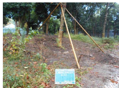
写真 6.8.3-6 既存樹木の根回し
