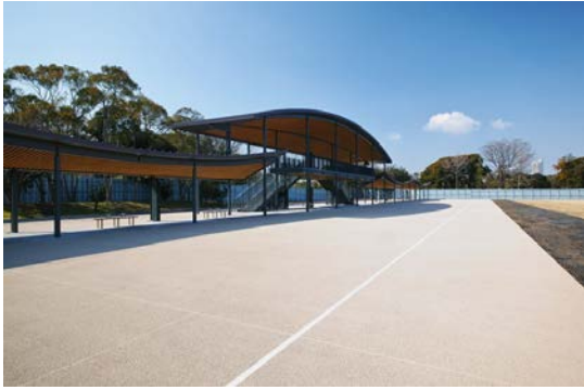
写真 5.1-1(1) 建築物（シェルター）の整備状況
