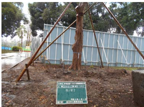
写真 6.8.3-5 既存樹木の根回し
