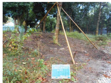
写真 6.8.2-6 既存樹木の根回し
