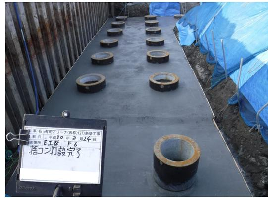
写真 8.2-10 捨てコンクリート打設状況
