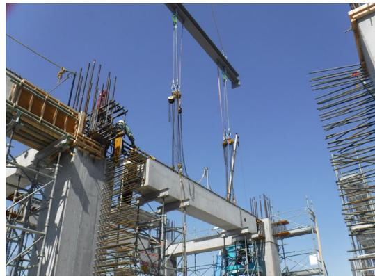
写真 8.2-6 PCa 化の状況 (梁工事)
