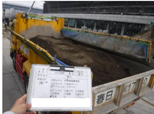
写真 8.2-2 建設泥土の再資源化施設への搬入
