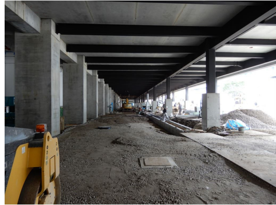
写真 8.3-2 再生砕石の使用状況
