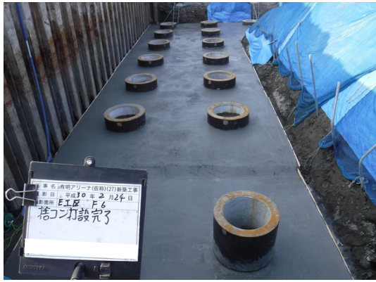
写真 8.3-1 捨てコンクリート打設状況
