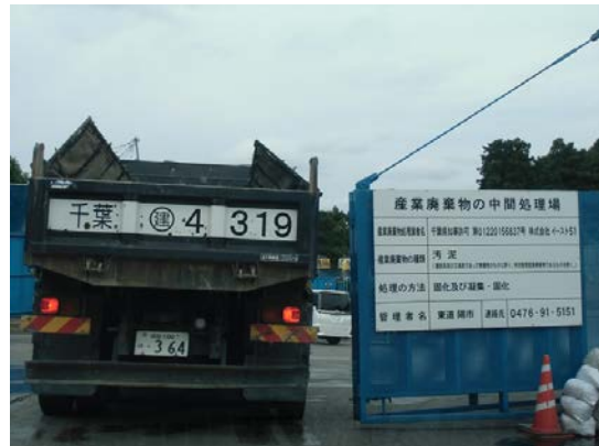
写真 8.4-2 建設汚泥の再資源化施設への搬入
