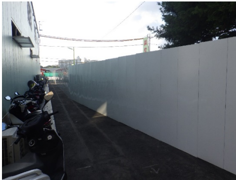
写真 8.1-11 南エリア地下道スロープ施工範囲における鋼製仮囲い (2m)
