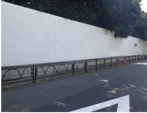
写真 8.1-9 北エリアにおける鋼製仮囲い (3m)
