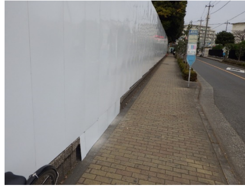
写真 8.1-10 北エリア地下道スロープ施工範囲における鋼製仮囲い (3m)
