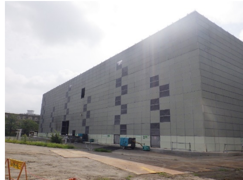
写真 8.1-14 工事範囲周辺の防じんカバー
