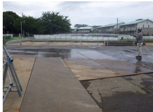
写真 8.1-20 鉄板の設置及び清掃
