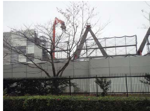
写真 8.1-12 パネル+防音シート
