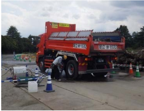
写真 8.1-1 タイヤ洗浄設備
