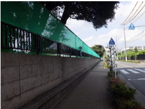
写真 8.1-19 飛散防止シート
