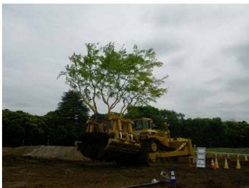
写真 8.2-5 モミジの移植状況
