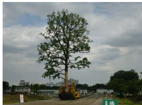
写真 8.2-6 クヌギの移植状況
