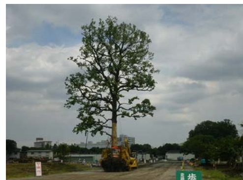
写真 8.8-6 クヌギの移植状況
