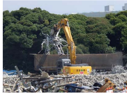
写真 8.8-2 分別解体工事
