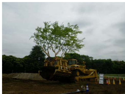
写真 8.8-5 モミジの移植状況
