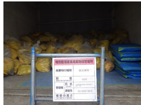
写真 8.8-4 アスベスト保管状況
