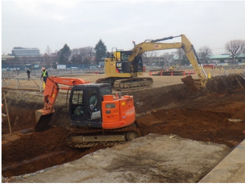
写真 8.8-1 建設発生土埋戻し
