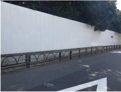
写真 8.6-7 北エリアにおける鋼製仮囲い (3m)
