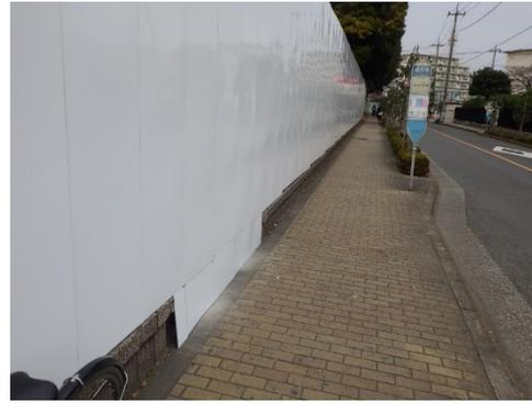
写真 8.6-8 北エリア地下道スロープ施工範囲における鋼製仮囲い (3m)
