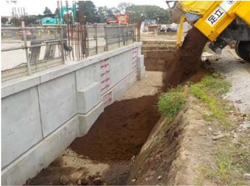
写真 8.9-1 建設発生土埋戻し
