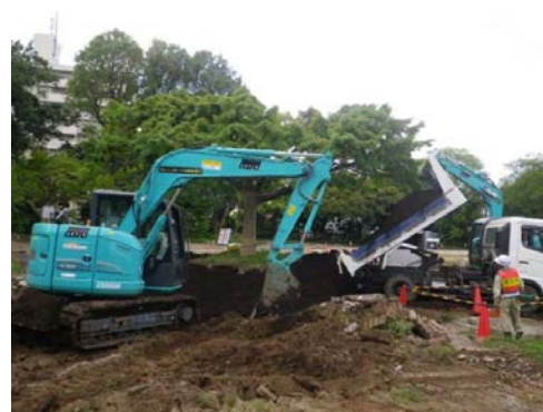
写真 8.5-2 植栽基盤の整備状況
