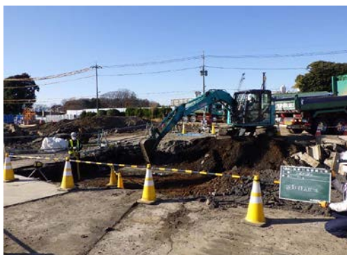
写真 8.2-1 汚染土壌の掘削除去
