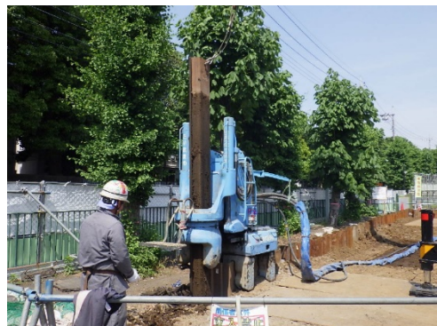
写真 8.6-14 サイレントパイラー工法
