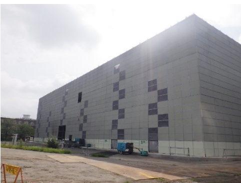
写真 8.1-15 工事範囲周辺の防じんカバー
