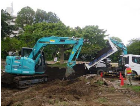
写真 8.4-2 植栽基盤の整備状況
