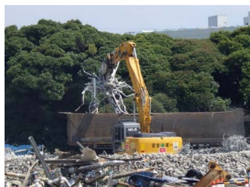
写真 8.9-2 分別解体工事
