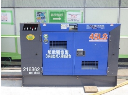
写真 8.1-17 第3次対策型建設機械
