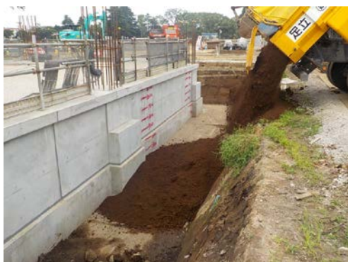
写真 8.9-1 建設発生土埋戻し
