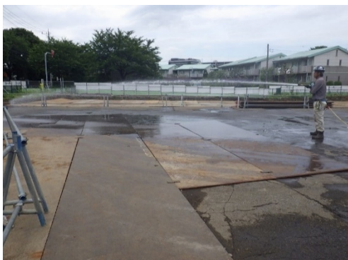
写真 8.1-21 鉄板の設置及び清掃
