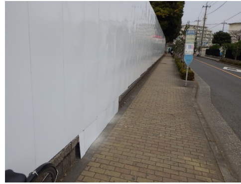
写真 8.6-8 北エリア地下道スロープ施工範囲における鋼製仮囲い (3m)
