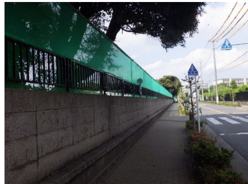
写真 8.1-20 飛散防止シート
