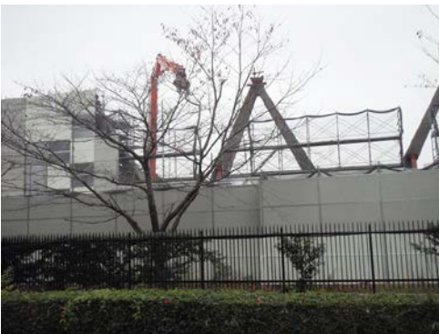
写真 8.1-13 パネル+防音シート
