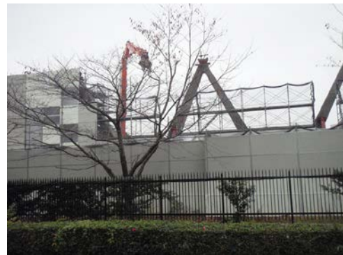
写真 8.6-10 パネル+防音シート
