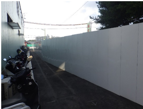
写真 8.6-9 南エリア地下道スロープ施工範囲における鋼製仮囲い (2m)
