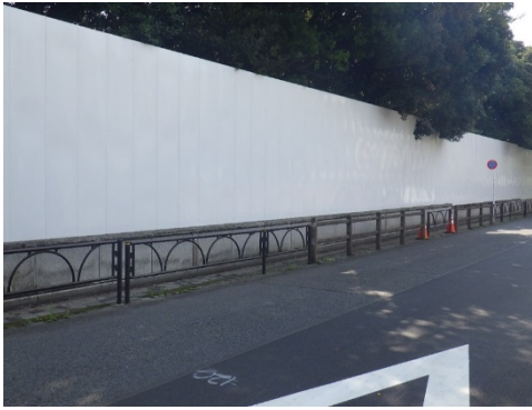
写真 8.6-7 北エリアにおける鋼製仮囲い (3m)
