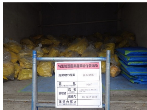
写真 8.9-4 アスベスト保管状況
