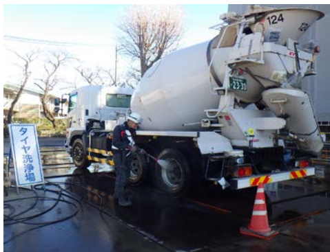
写真 8.1-1 タイヤ洗浄設備
