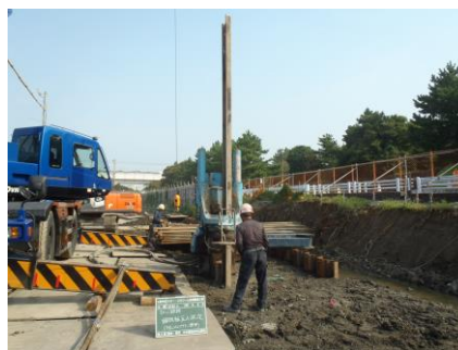
写真 8.5-6 サイレントパイラー工法
