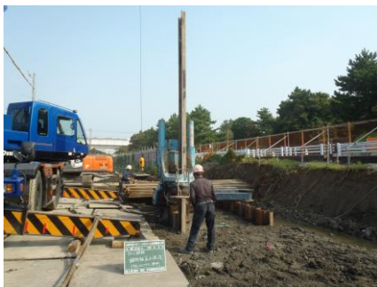
写真 8.7-9 サイレントパイラー工法の採用
