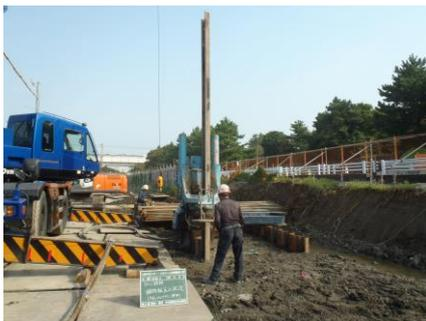
写真 8.7-9 サイレントパイラー工法の採用
