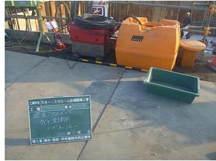
写真 8.1-2 タイヤ洗浄装置
