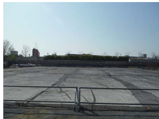
写真 8.1-4 飛散防止シート
