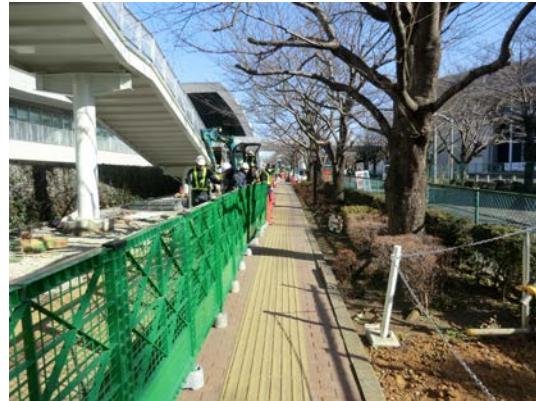
写真 8.15-2 バリケード設置の状況
