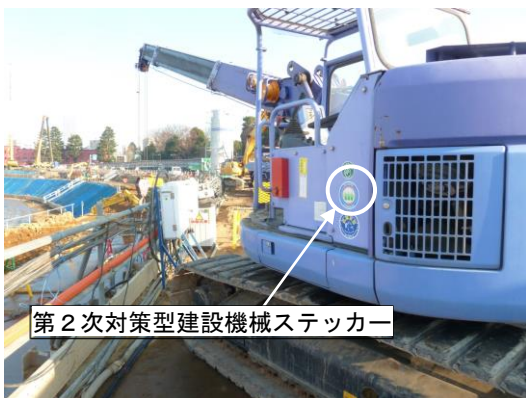
写真 8.1-7 排出ガス対策型建設機械の使用
