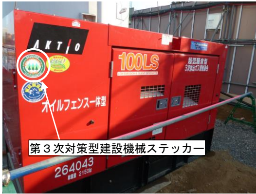
写真 8. 1-9 排出ガス対策型建設機械の採用
