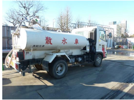
写真 8. 1-10 散水車による散水
