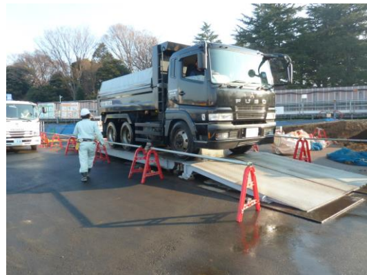
写真 8.1-4 トラックスケールによる計量
