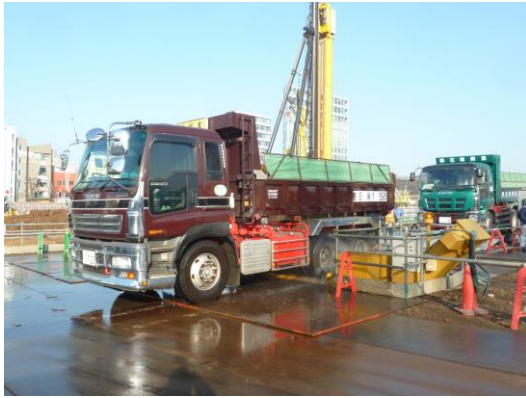
写真 8.1-1 タイヤ洗浄設備
