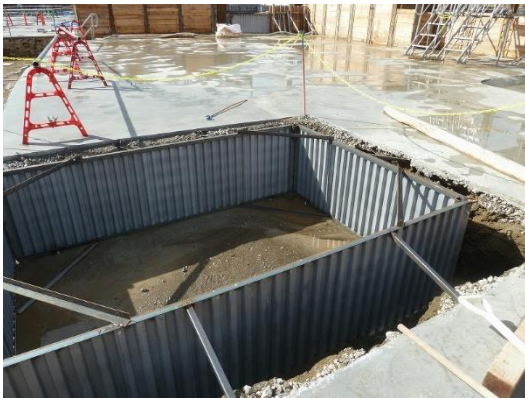
写真 8.14-3 鋼製型枠
