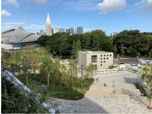
写真 8.19-1 通路空間 (その1) (計画地北西側)
