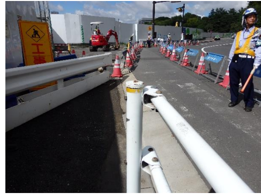
写真 8.25-2 道路占有工事での歩行者安全対策
