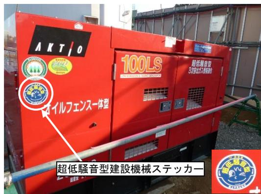
写真 8.7-6 超低騒音型建設機械の採用
