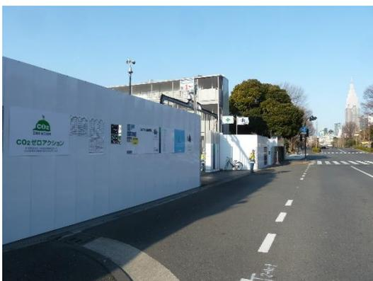
写真 8.7-5 仮囲い設置状況 (高さ 3.0m)
