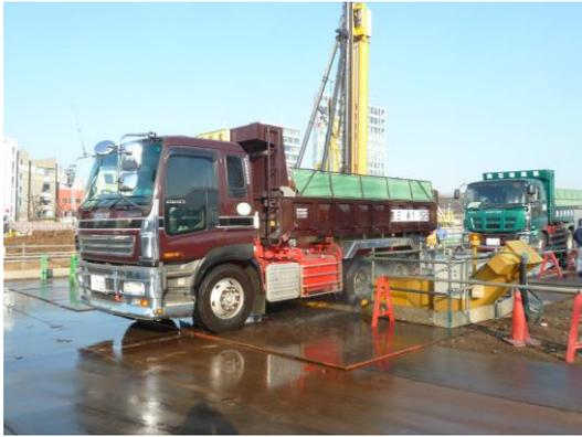
写真 8.1-1 タイヤ洗浄設備
