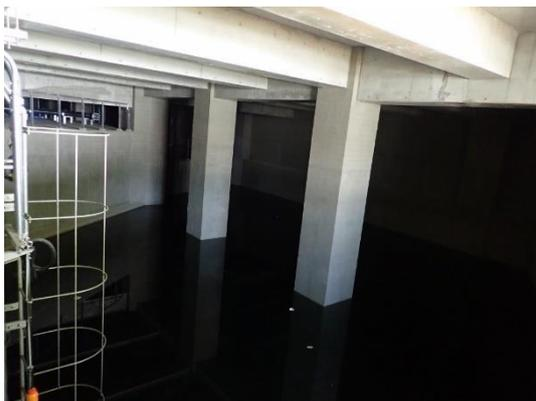
写真 8.13-1 雨水貯留槽
