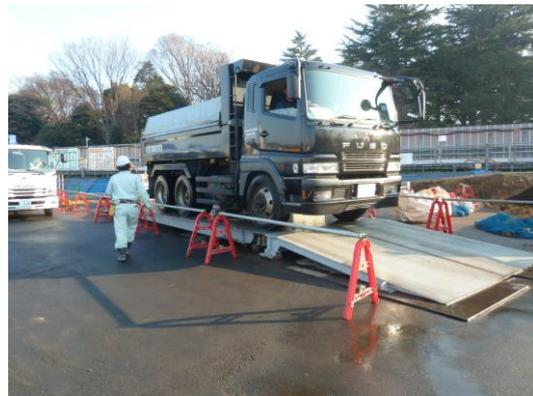
写真 8.1-4 トラックスケールによる計量
